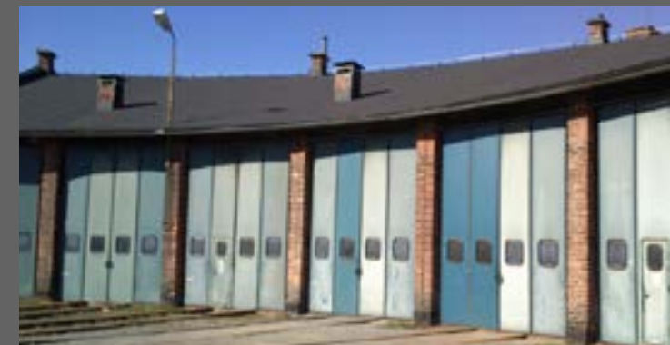
Lokstallar är speciella byggnader. Som den här i Mellansel. Ofta rätt gamla och häftiga – men byggda innan energibesparing blev stort. Så det finns mycket besparingar att göra när vinter och kyla sätter in.
